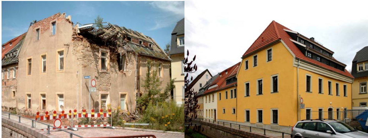
Vom Problemobjekt zum Schmuckstück – gerettetes Denkmal in der Spülgasse 2 (Fertigstellung Dezember 2006)
